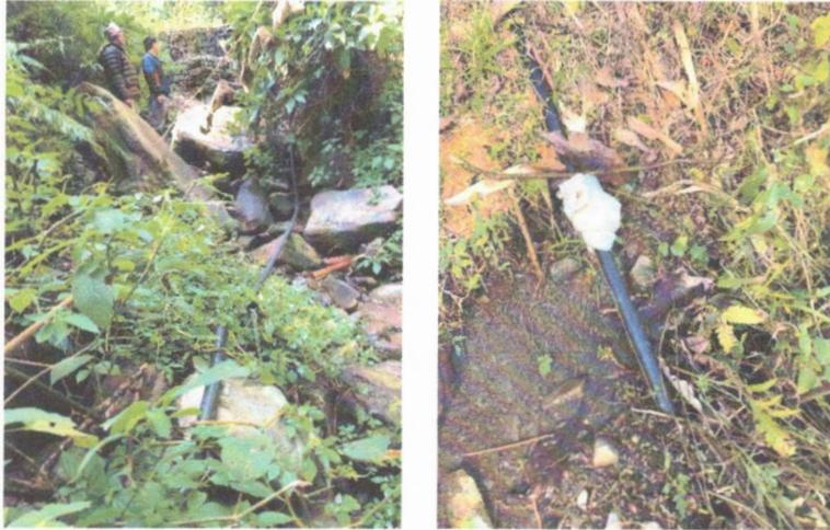
En la foto de la derecha se puede ver una de las tuberías que lleva el agua a pueblo con fuertes pérdidas de agua y en la foto izquierda una tubería que perdía agua y para evitar pérdidas se ha puesto una bolsa de plástico.
